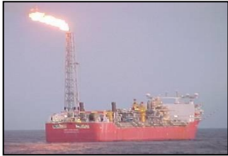
Terra Nova FPSO
